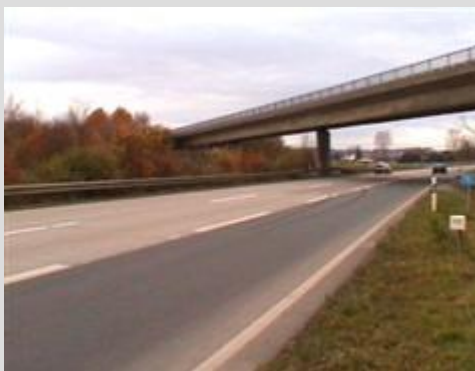
事故现场照片2：发生事故的路段
